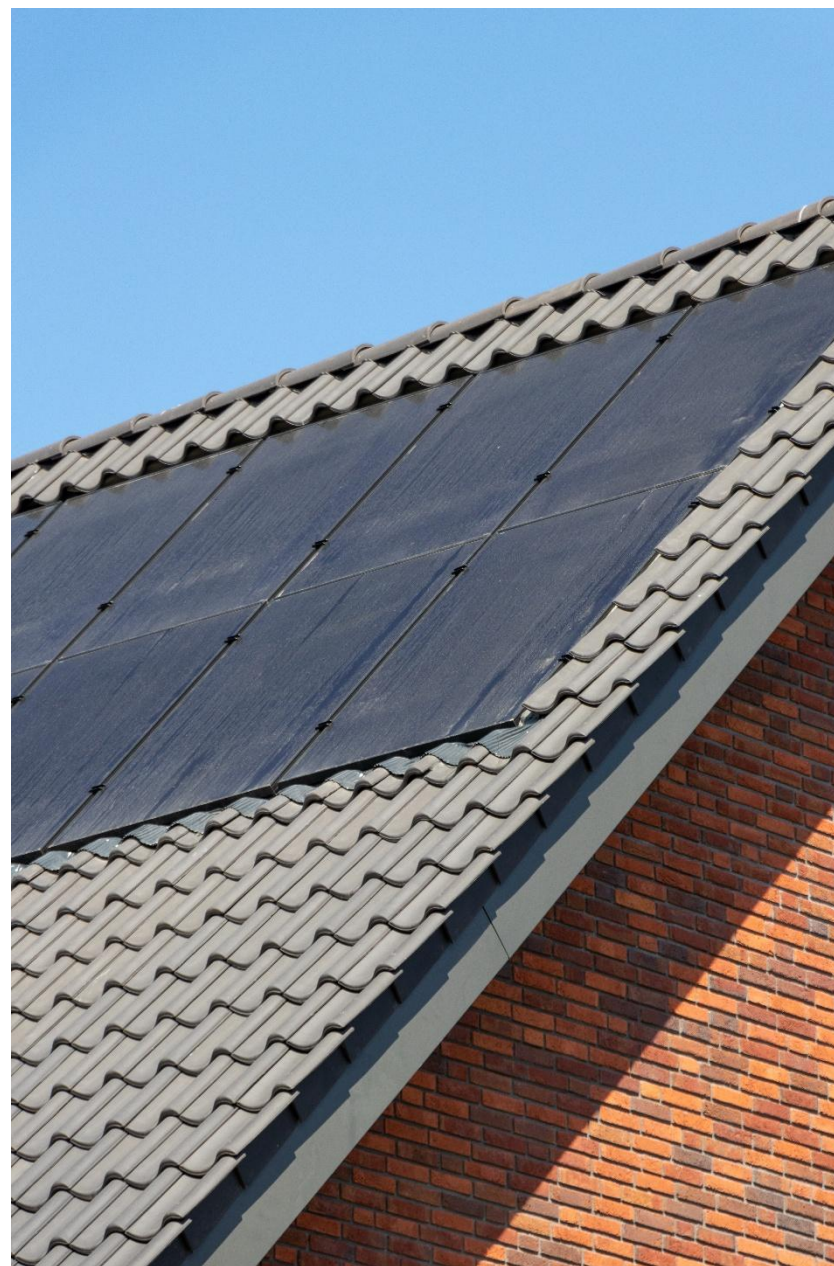
Afbeelding 15. Woning in Udenhout met zonnepanelen
