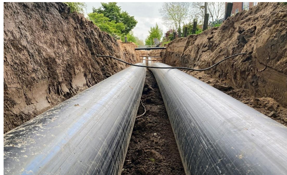
Afbeelding 8: Warmtenetleidingen in de grond
