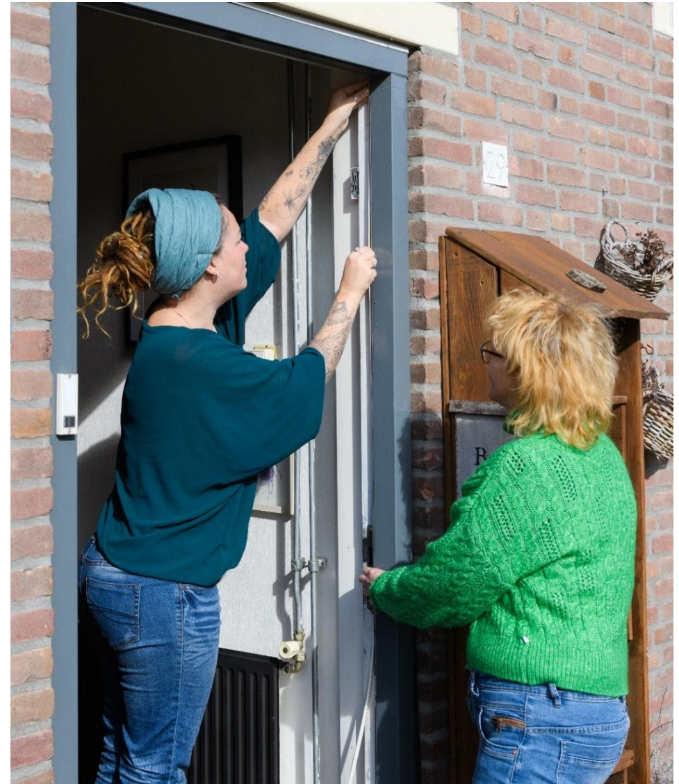
Afbeelding 5. Kierdichting met een energiecoach.
